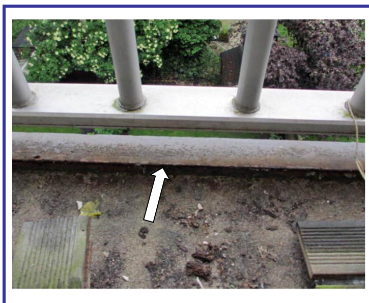
balkon; randbalk roestig
